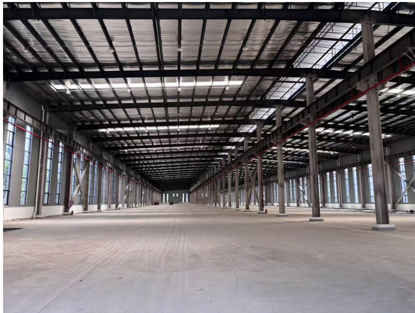
图 2-9 项目已建厂房内部情况
