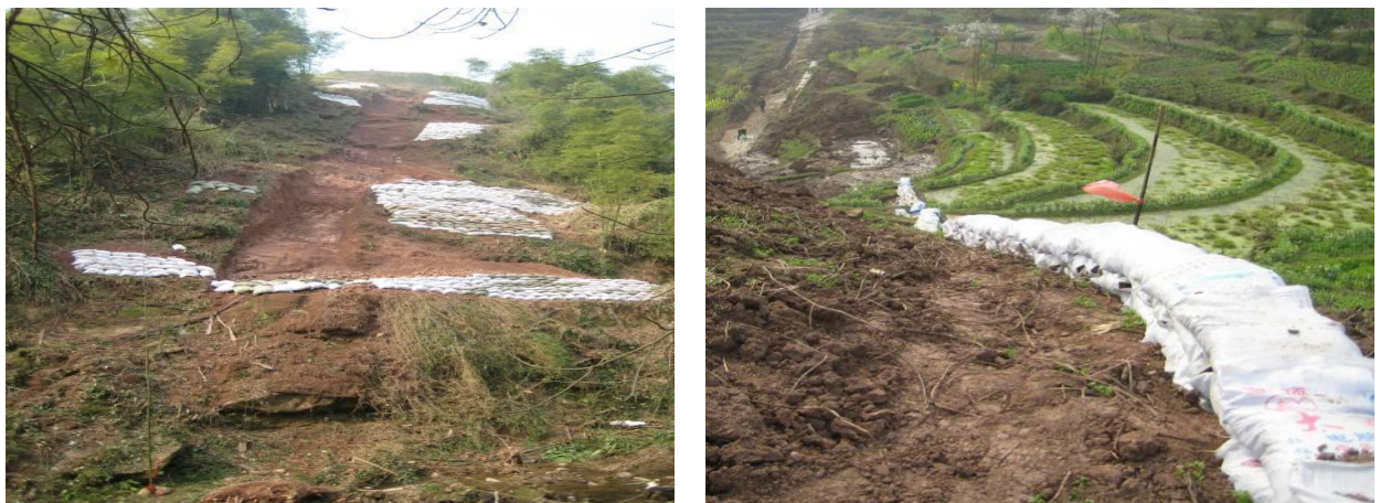
图 2-4 施工作业带临时水工保护措施示意图
